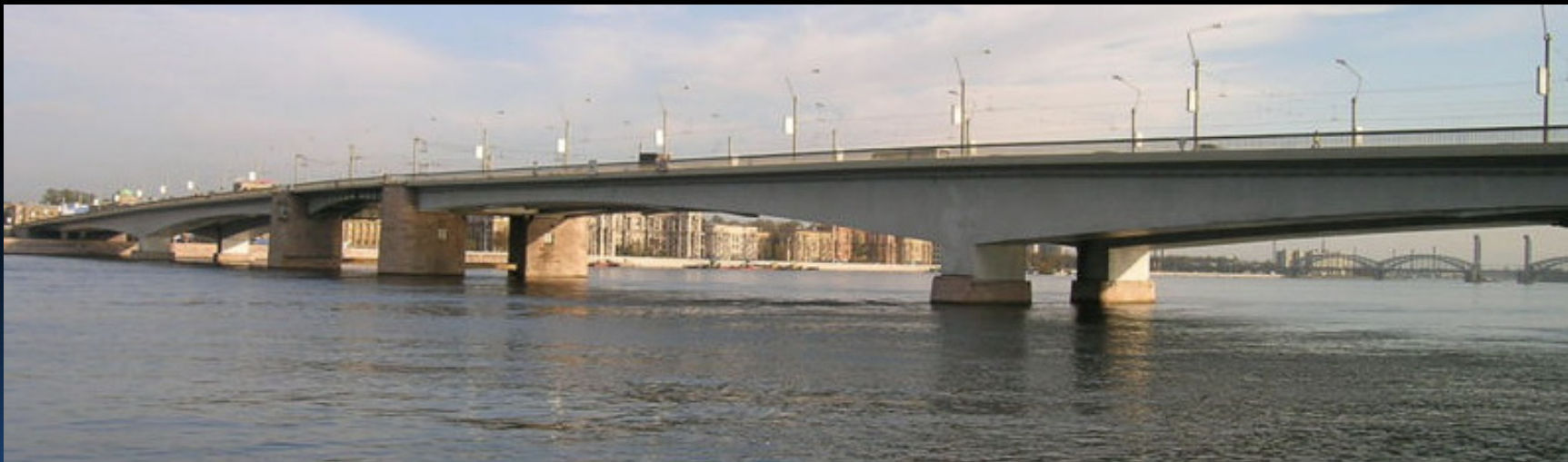
Мост Александра Невского.
